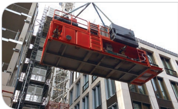
Система регенерации бурового раствора бурения геотермальной скважины
